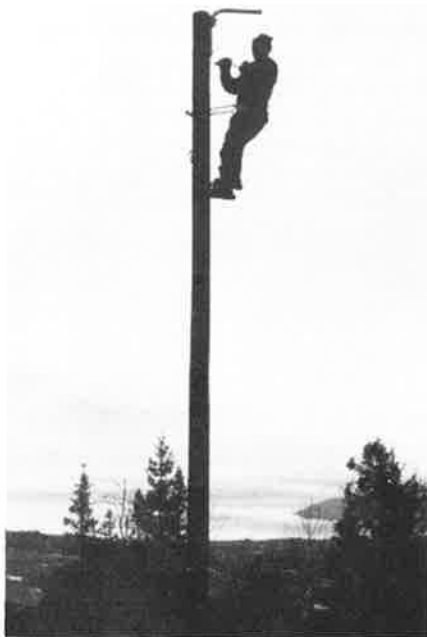
Erling Kråkmo i ferd med å montere lysarmatur i den første lysløypa.
