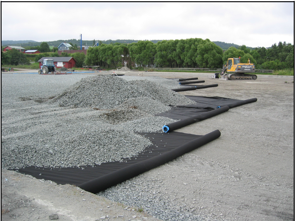
Duk i bunnen, innfylling av pukk.
